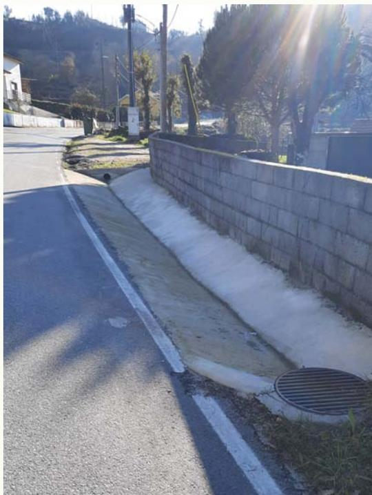
Reparação de bermas, valetas e condução de águas pluviais - Meãs - UF O. Frades, Souto de Lafões e Sejães
